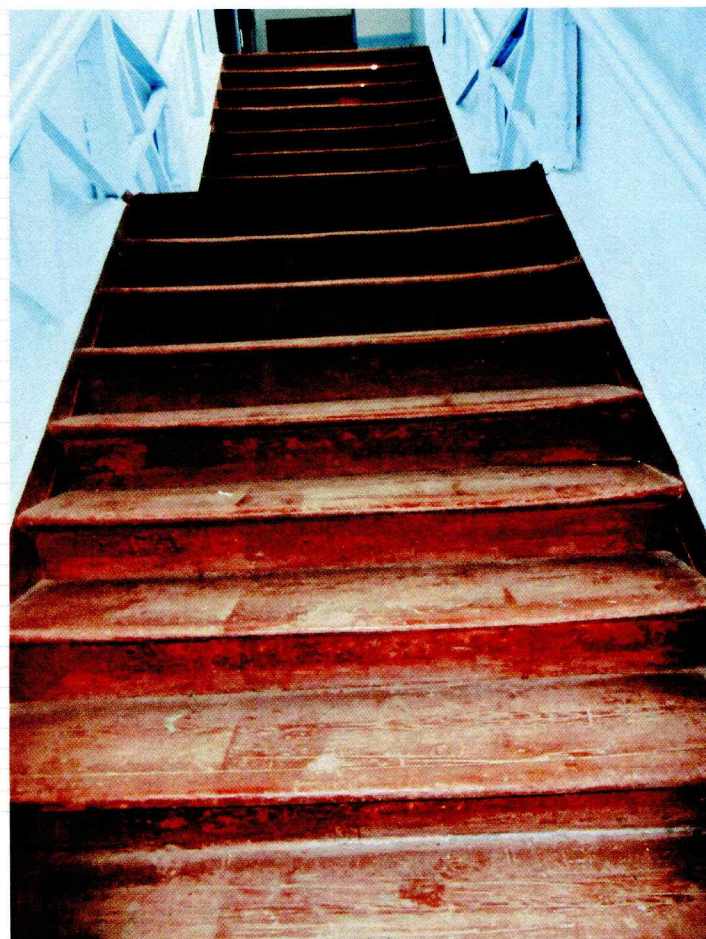
Фото 6. «Дом жилой Грязновых. Здесь жил русский советский военный деятель Д.П. Парский», 1820-е гг.; 1908-1914 гг., по адресу: г. Кострома, ул. Шагова, 10А. Фрагмент 2-хмаршевой лестницы
