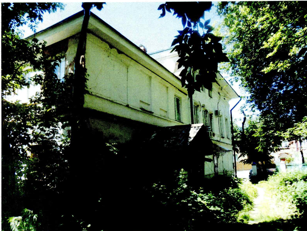
Фото 3. «Дом жилой Грязновых. Здесь жил русский советский военный деятель Д.П. Парский», 1820-е гг.; 1908-1914 гг., по адресу: г. Кострома, ул. Шагова, 10А. Вид со стороны бокового(северо – восточного) фасада
