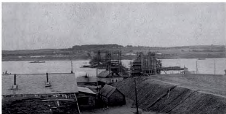
Строительство железнодорожного моста через р. Волгу
