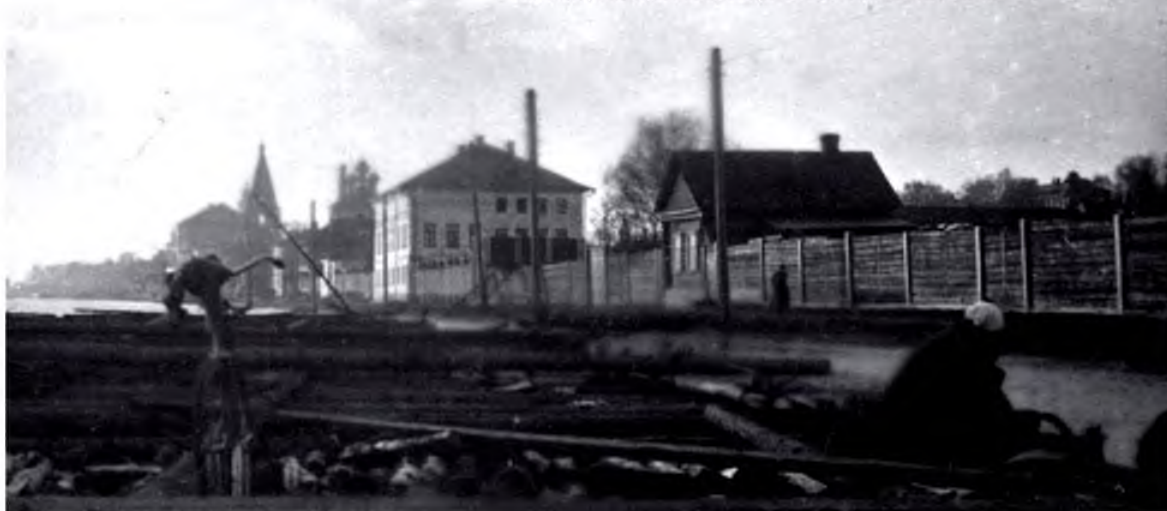
Работы на сплаве
