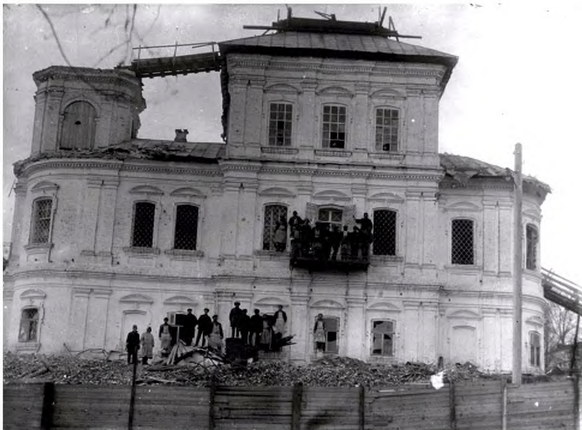
Слом Петропавловской церкви
