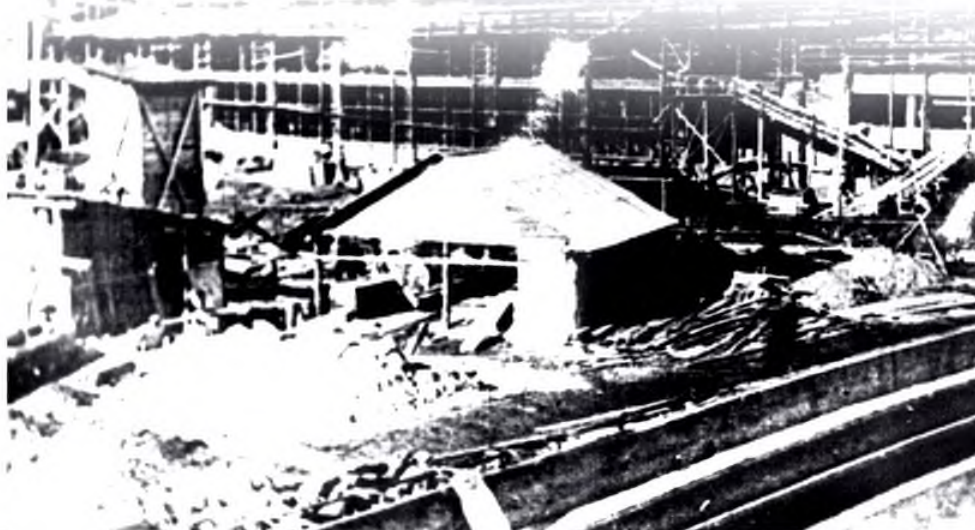
Корпуса будущих производственных площадей.
