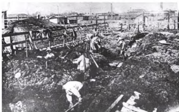
Начало строительства льнокомбината системы И.Д. Зворыкина
