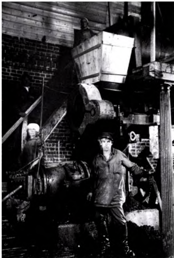
Костромской кирпичный завод: кирпичеделательная машина
