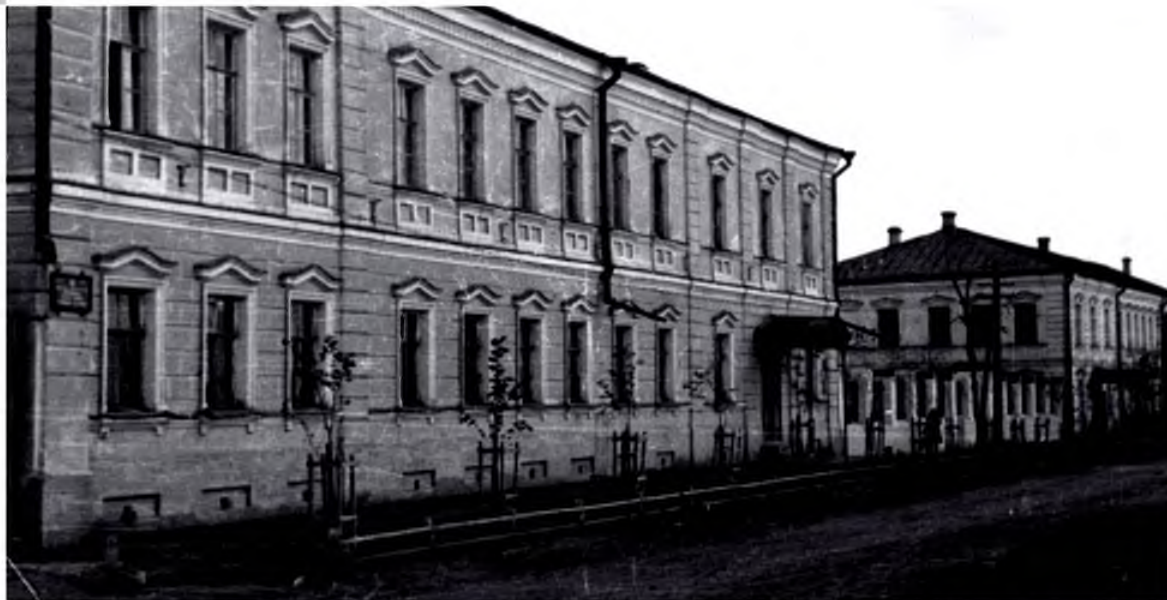
Здание сельхозинститута на ул. 1 Мая
