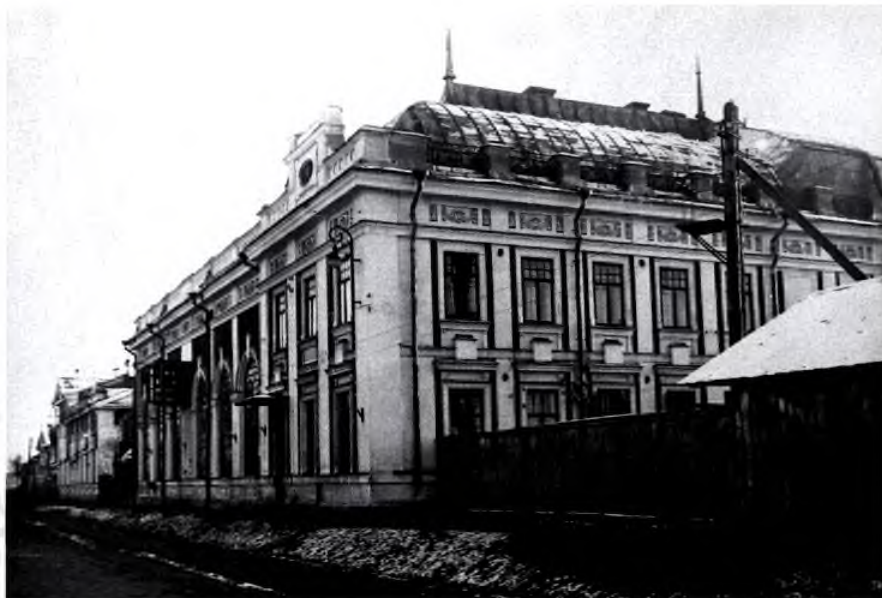
Здание бывшей дизельной электростанции
