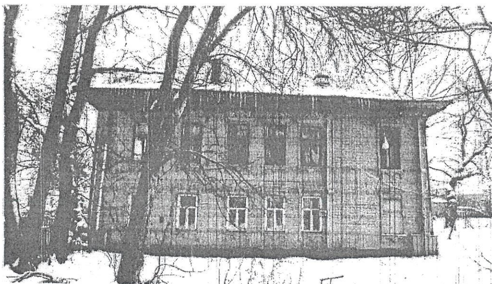
Фото 2. Вид со стороны дворового (южного) фасада
