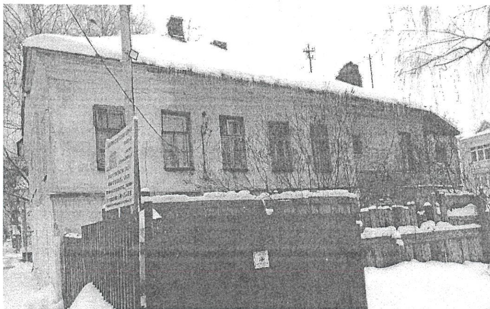
Фото 2. Вид со стороны бокового (северо-западного) фасада
