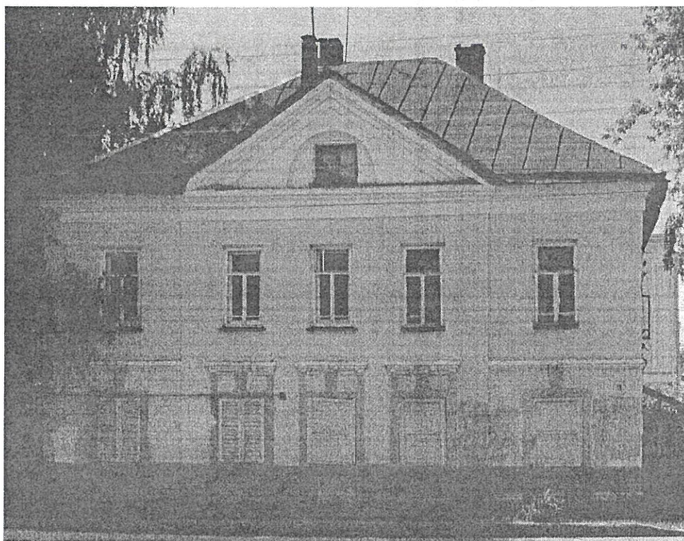
Фото 1. Вид со стороны главного (северо-восточного) фасада
