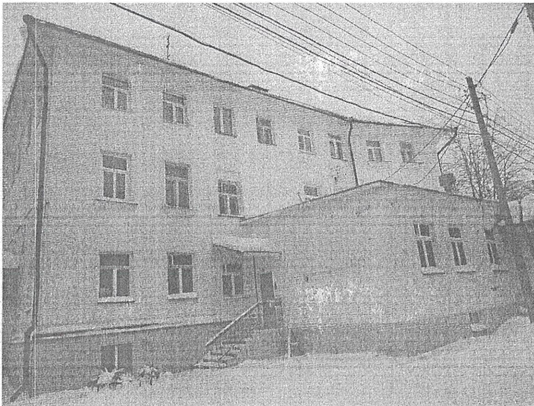
Фото 3 Дворовый (южный) фасад
