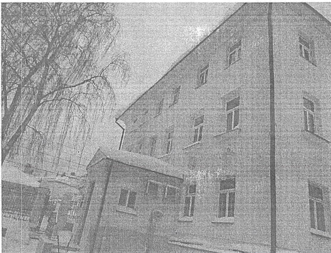
Фото 4 Боковой (западный) фасад
