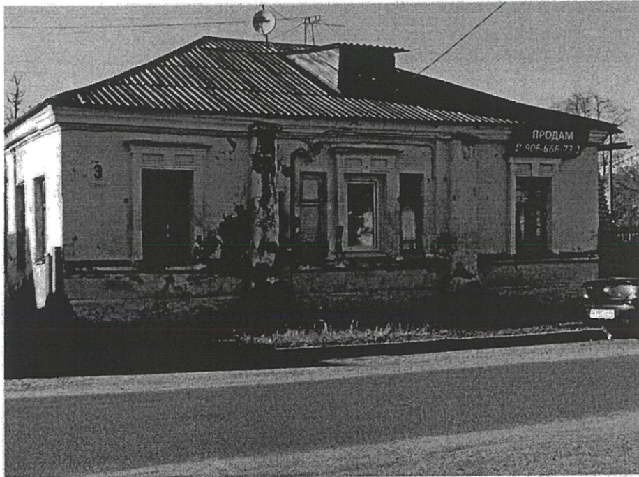
«Дом жилой Акатова, 1-я пол. XIX в.» г. Кострома, ул. Комсомольская, 31 Главный (юго-восточный) фасад
