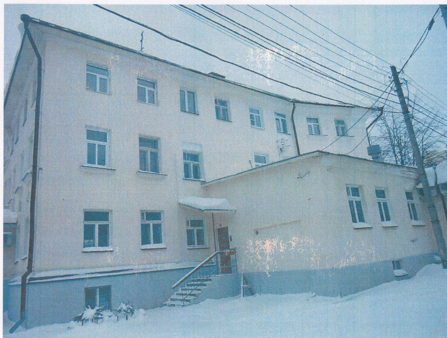
Фото 3 Дворовый (южный) фасад
