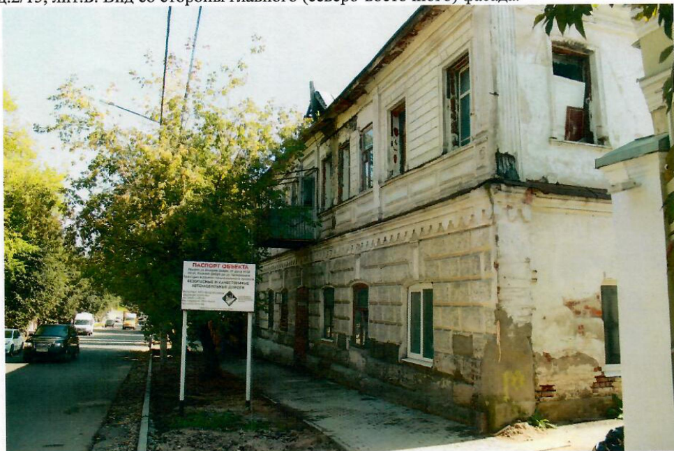
Фото 2. «Дом жилой», 2-я пол. XIX в., местоположение: г. Кострома, ул. Кооперации, д.2/15, лит.Б. Вид со стороны главного фасада.
