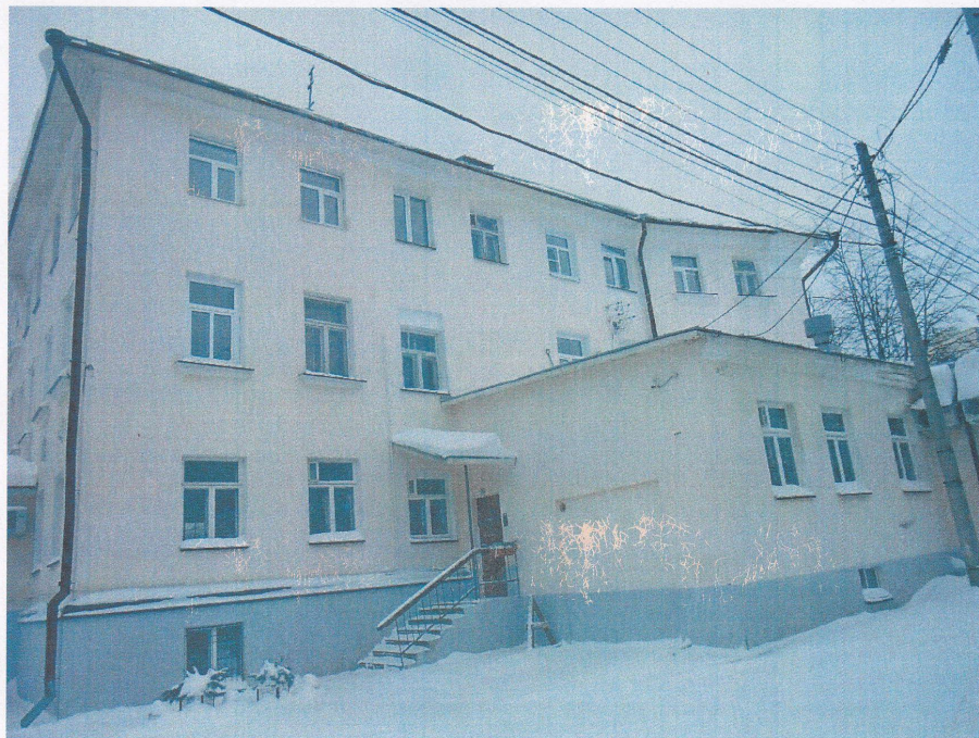
Фото 3 Дворовый (южный) фасад
