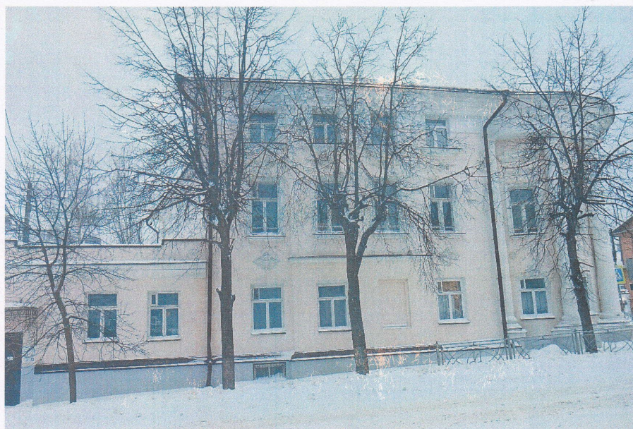
Фото 2. Вид со стороны улицы Крестьянской (восточный фасад)
