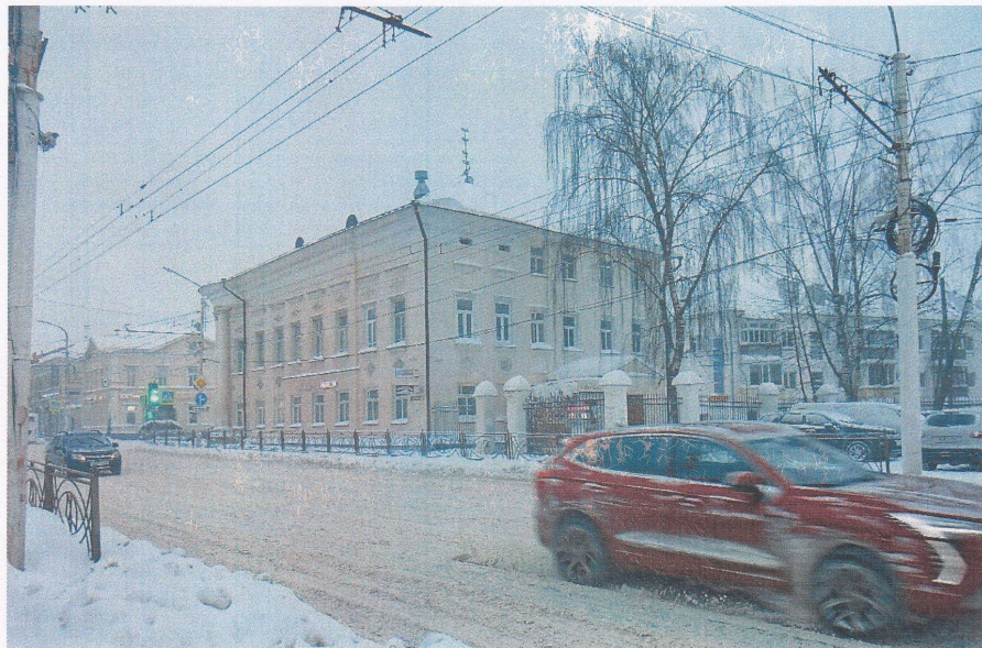
Фото 1. Общий вид со стороны ул. Советской, главный (северный) фасад
