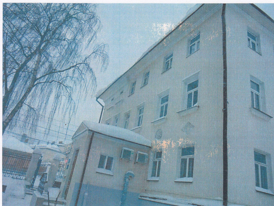
Фото 4 Боковой (западный) фасад
