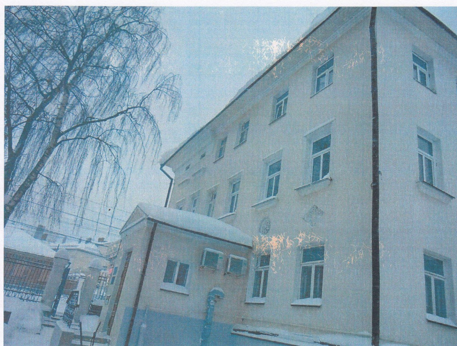
Фото 4 Боковой (западный) фасад
