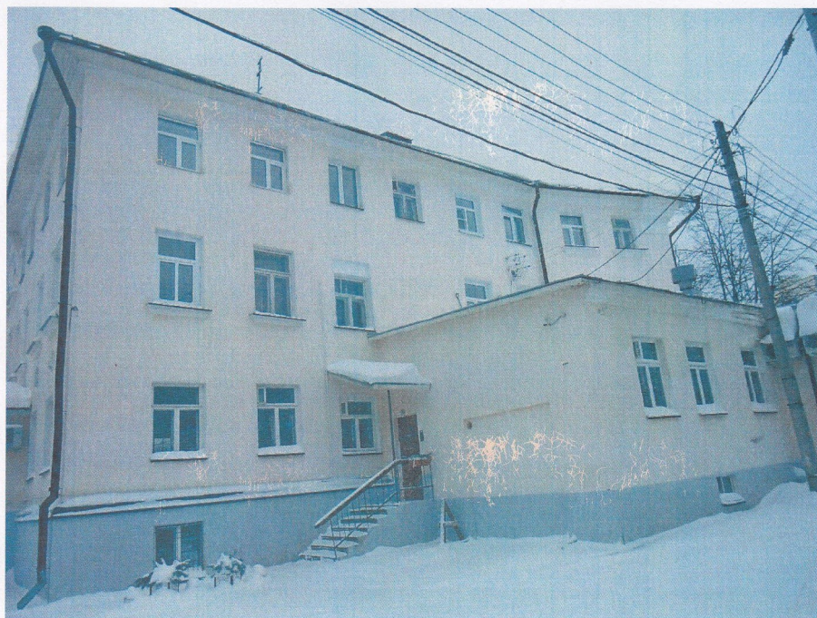
Фото 3 Дворовый (южный) фасад
