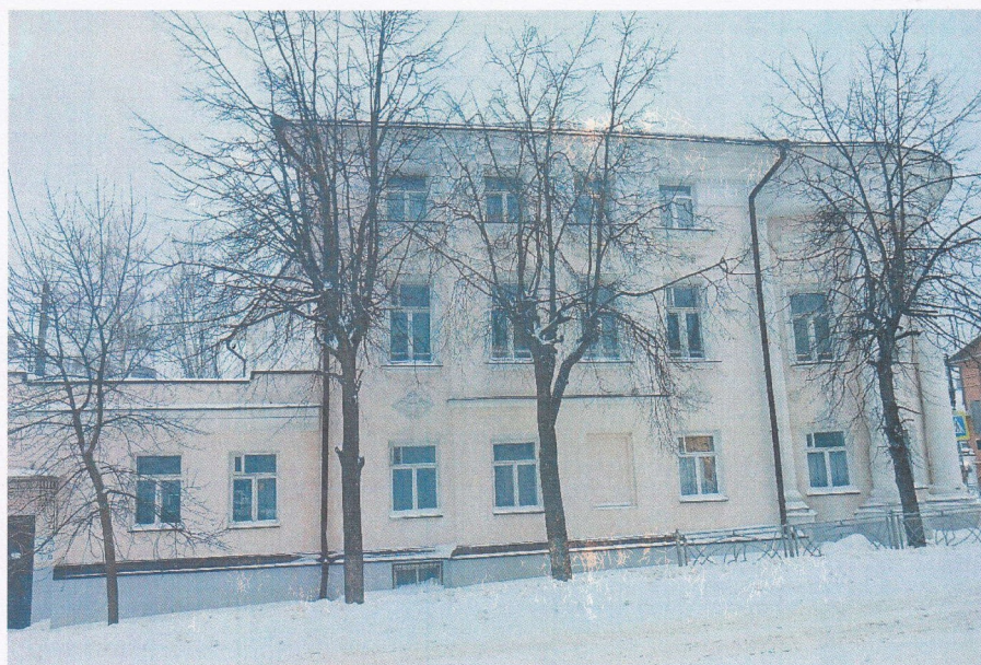
Фото 2. Вид со стороны улицы Крестьянской (восточный фасад)
