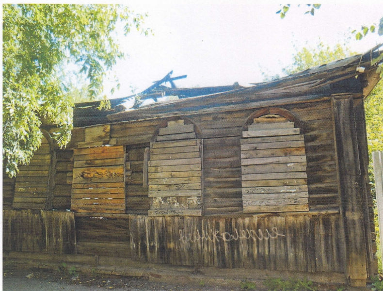
Фото 1. Фрагмент главного (западного) фасада
