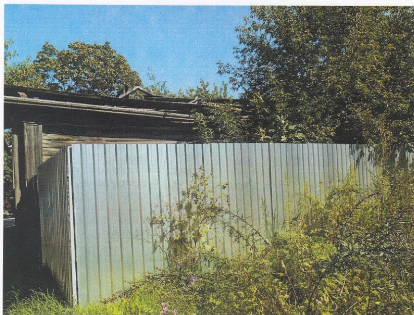
Фото 3 Фрагмент бокового (южного) фасада
