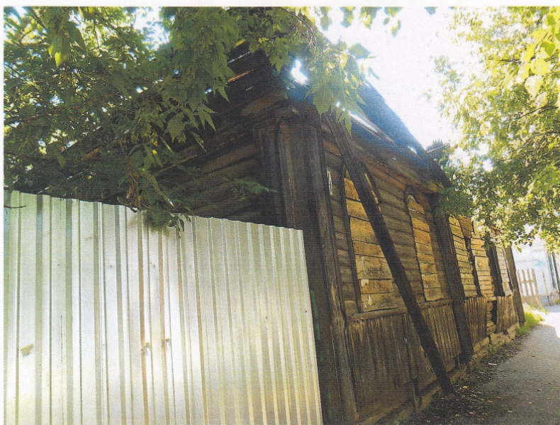
Фото 2. Фрагмент бокового (северного) и главного (западного) фасадов
