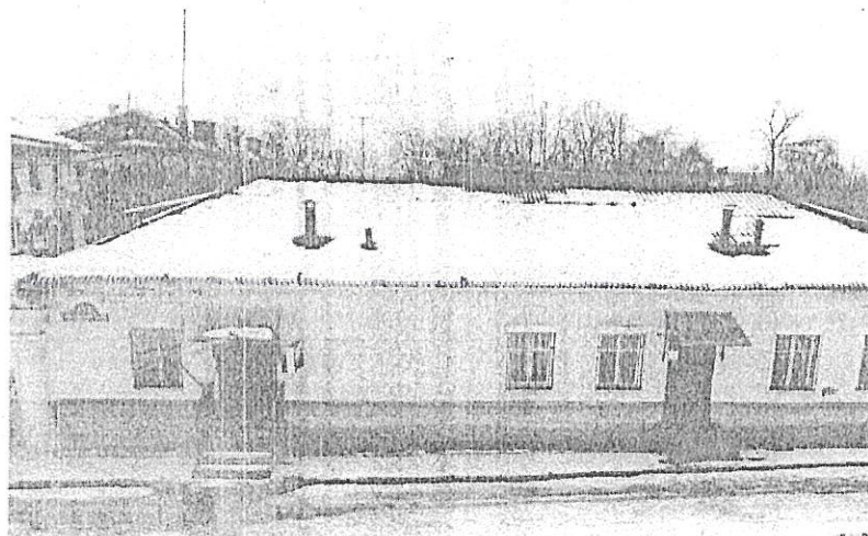
Фото №1 главный (северо-восточный) фасад (фото 27.01.2021)
