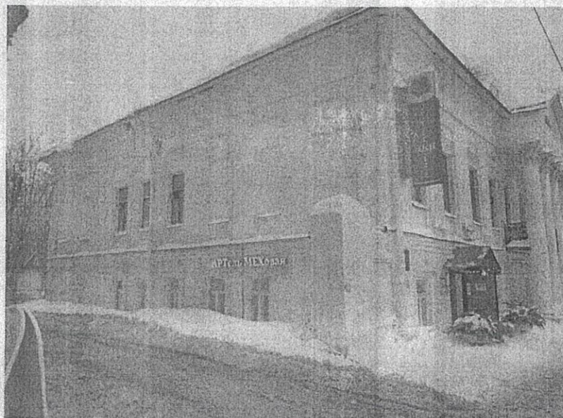
Фото 3. Вид со стороны бокового (северного) фасада
