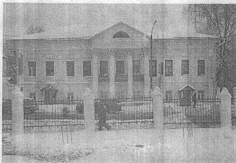
Фото 2. Вид со стороны главного (восточного) фасада
