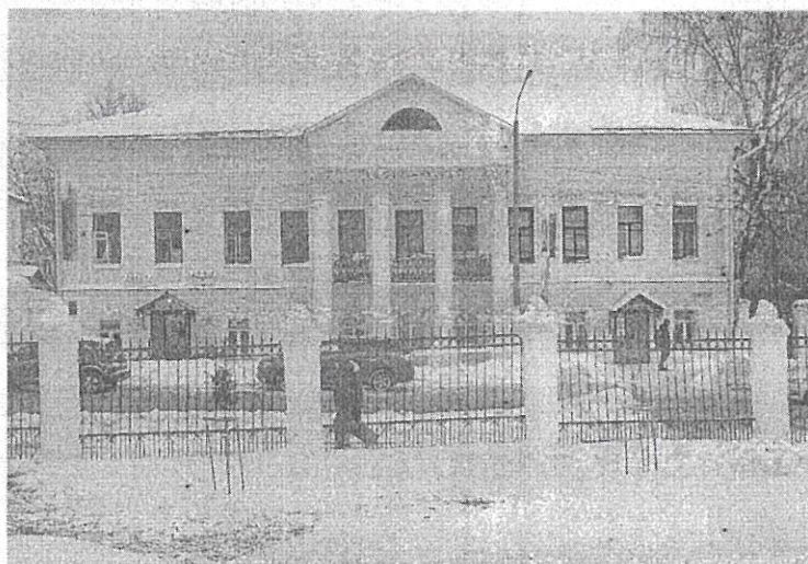
Фото 2. Вид со стороны главного (восточного) фасада
