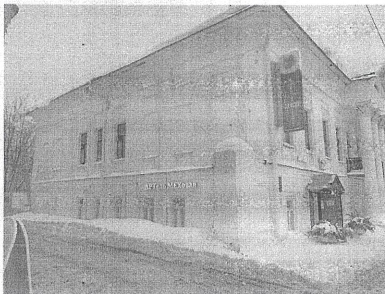
Фото 3. Вид со стороны бокового (северного) фасада
