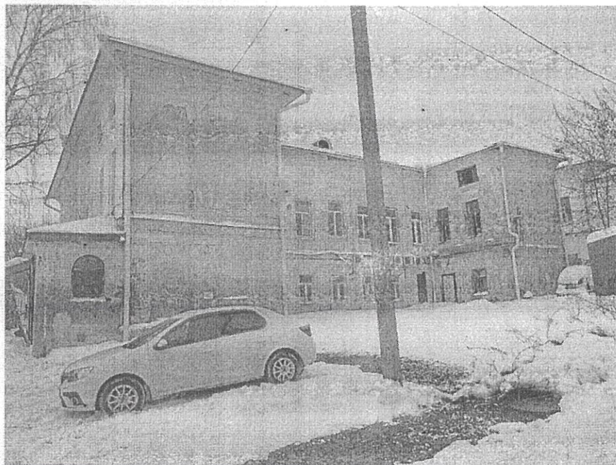
Фото 5. Вид со стороны дворового (западного) фасада
