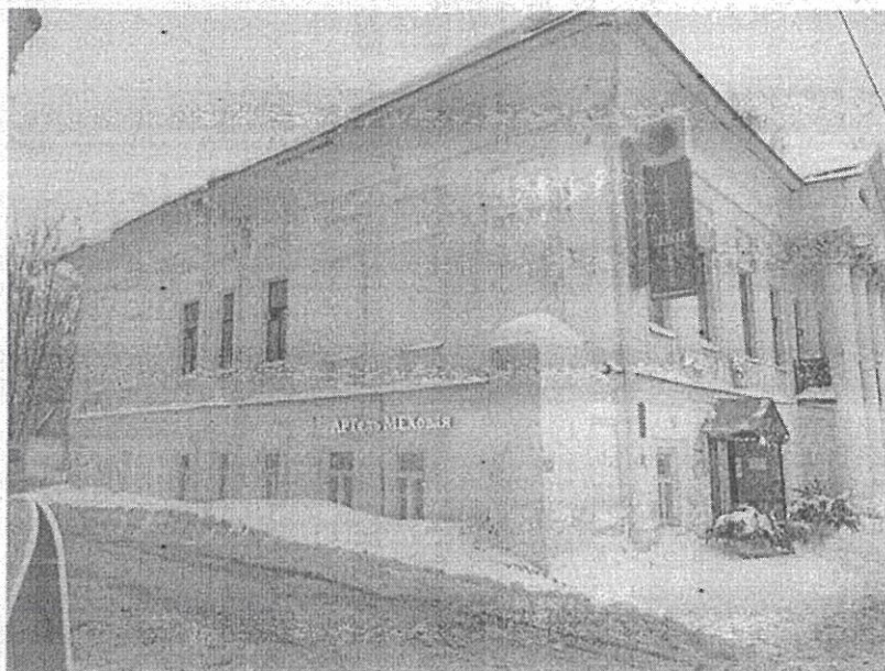
Фото 3. Вид со стороны бокового (северного) фасада
