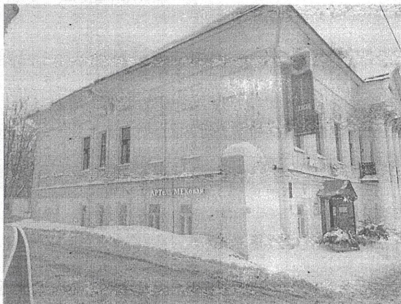
Фото 3. Вид со стороны бокового (северного) фасада
