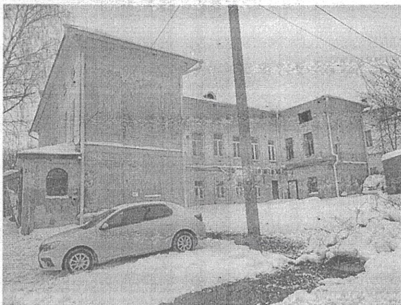
Фото 5. Вид со стороны дворового (западного) фасада
