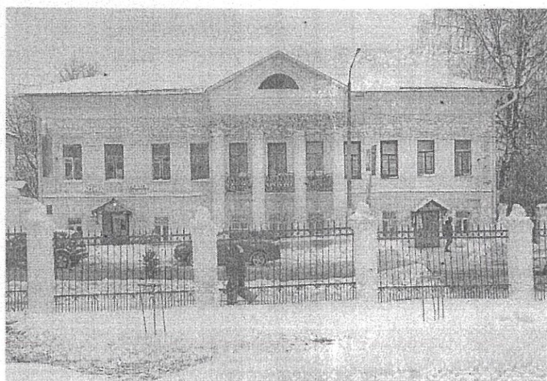
Фото 2. Вид со стороны главного (восточного) фасада
