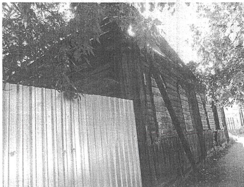
Фото 2. Фрагмент бокового (северного) и главного (западного) фасадов
