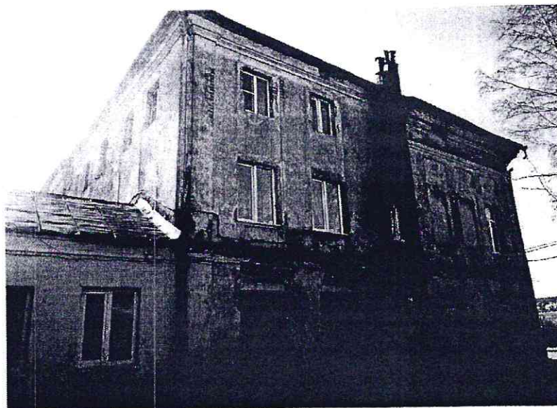
Фото 4. Вид со стороны бокового (северо-западного) фасада
