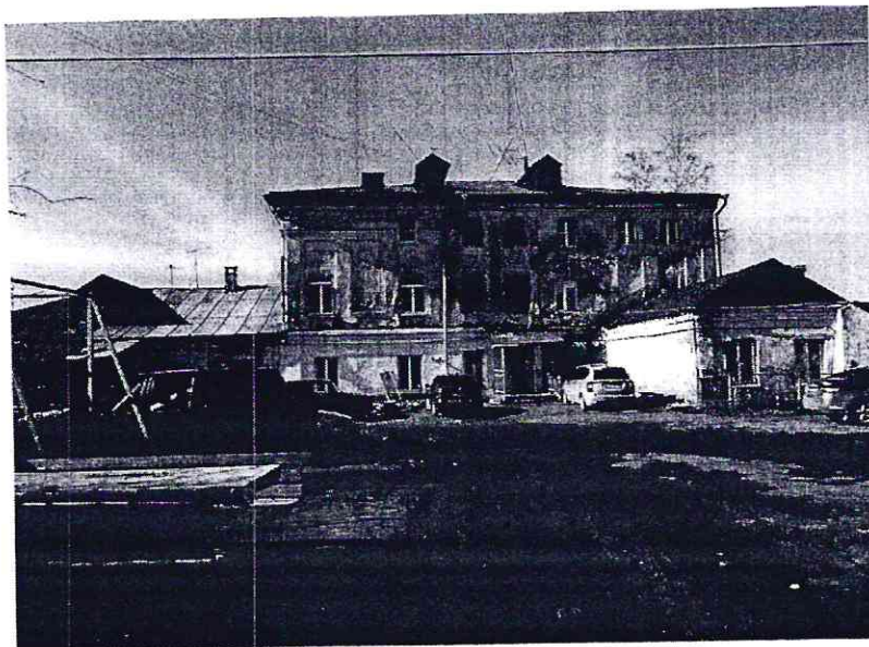
Фото 3. Вид со стороны дворового (северо-восточного) фасада
