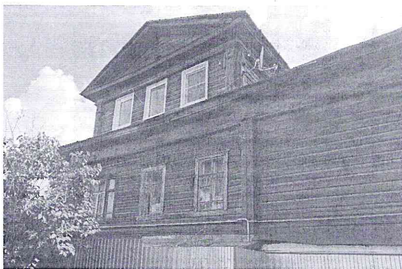
Фото 4. Дворовый (западный) фасад
