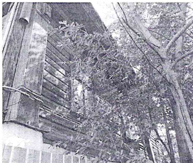
Фото 2. Боковой (южный) фасад
