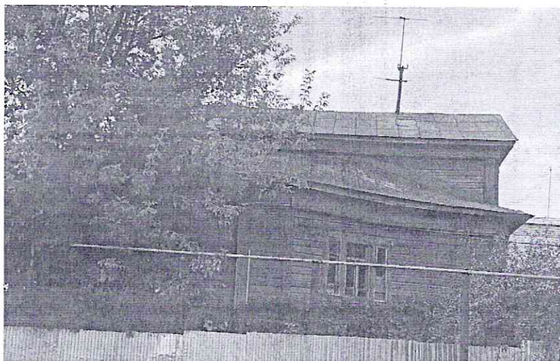
Фото 3. Боковой (северный) фасад
