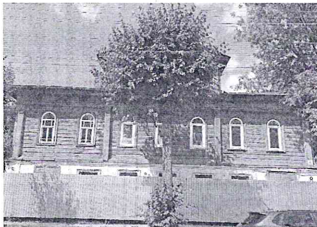
Фото 1. Главный (восточный) фасад
