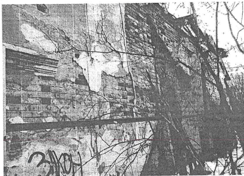
Фото 2. Вид со стороны бокового (восточного) фасада
