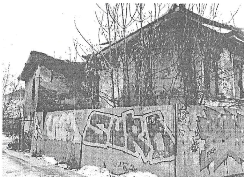
Фото 4. Вид со стороны бокового (западного) фасада
