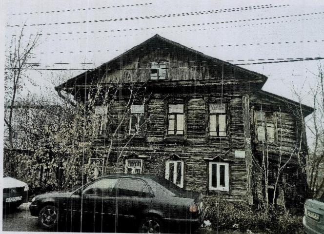
Фото 1. Главный (юго-западного) фасад
