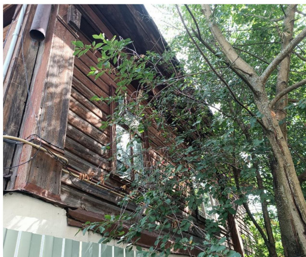
Фото 2. Боковой (южный) фасад
