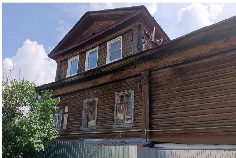
Фото 4. Дворовый (западный) фасад
