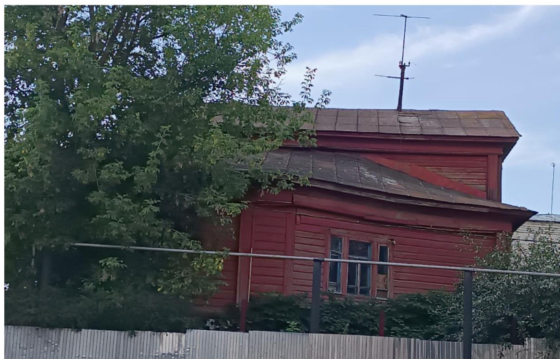
Фото 3. Боковой (северный) фасад
