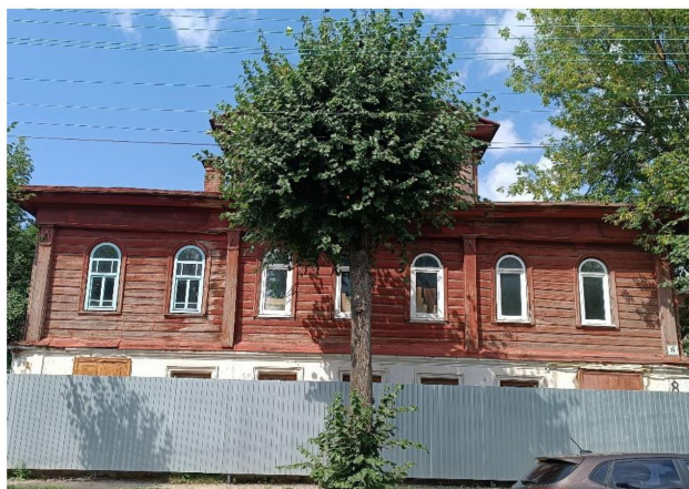
Фото 1. Главный (восточный) фасад
