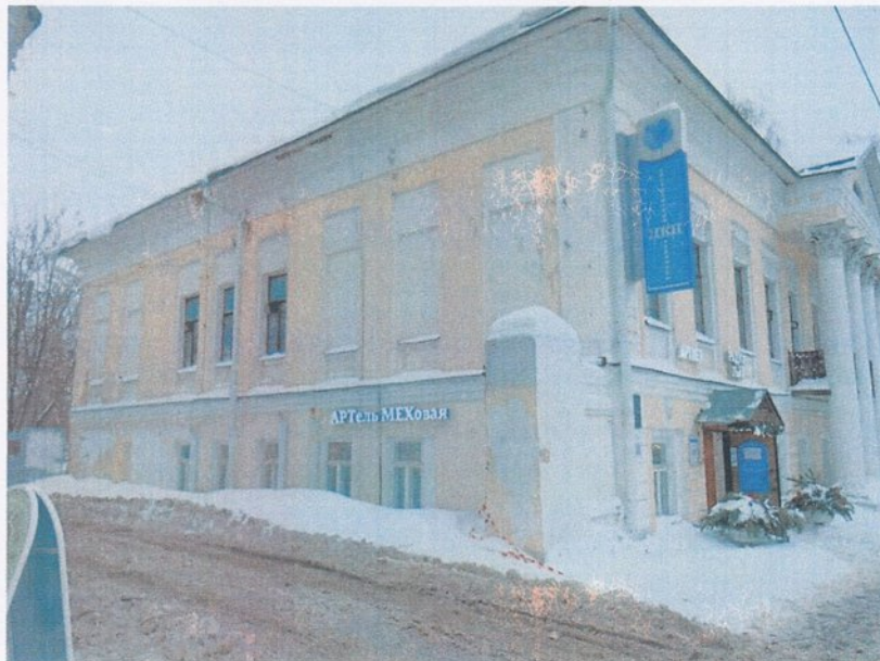
Фото 3. Вид со стороны бокового (северного) фасада
