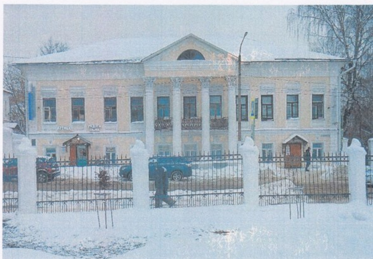
Фото 2. Вид со стороны главного (восточного) фасада
