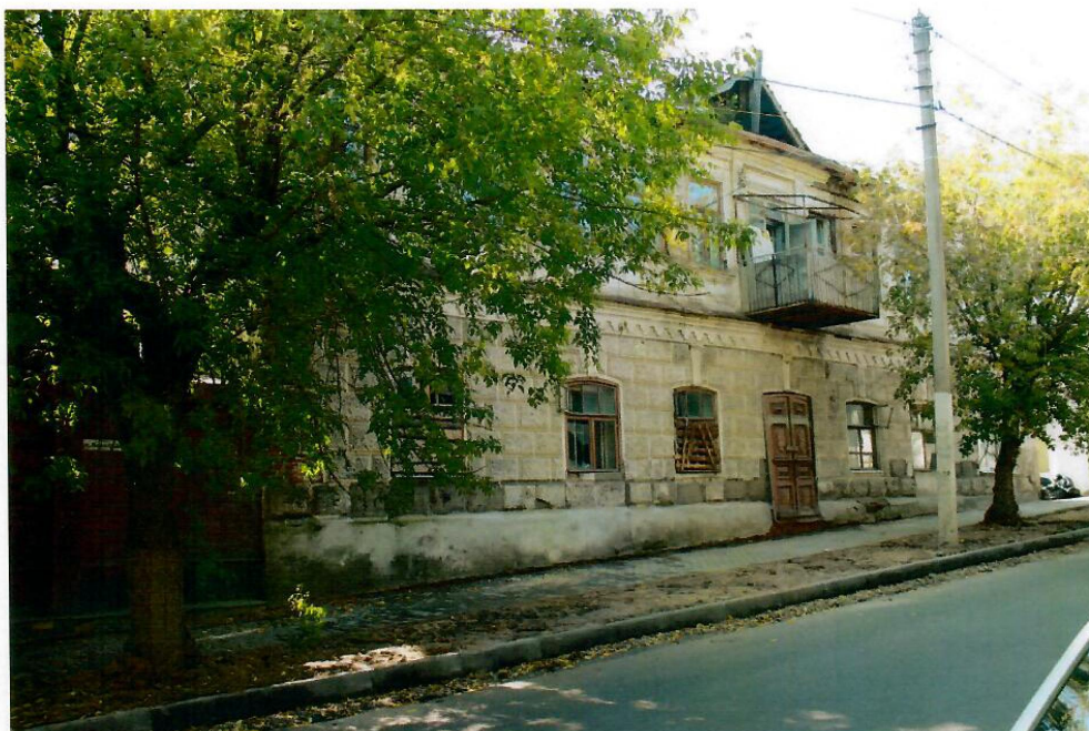
Фото 1. «Дом жилой», 2-я пол. XIX в., местоположение: г. Кострома, ул. Кооперации, д.2/15, лит.Б. Вид со стороны главного (северо-восточного) фасада.
