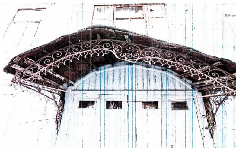
Фото 4. Фрагмент металлического козырька на ажурных кронштейнах
