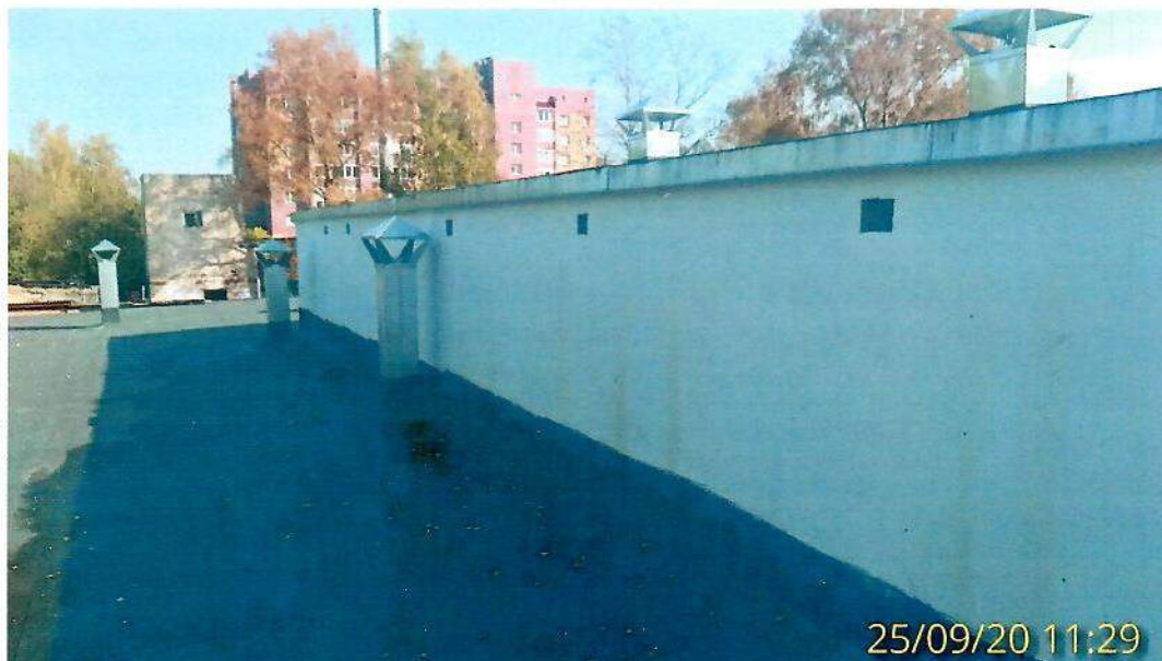
Фото 1. Капитальный ремонт кровли здания.
